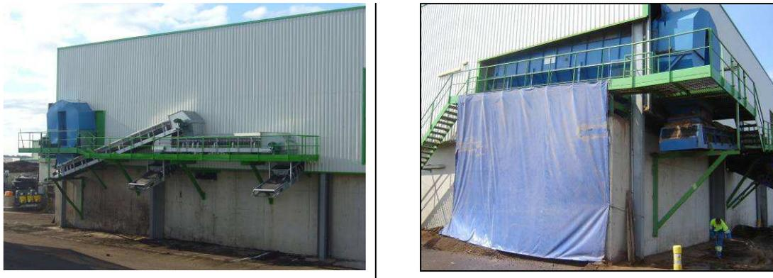
*Figure 13 : Traitement des poussières en zone criblage*
